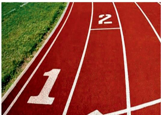
Toplam 15 mm. kalınlıkta uygulanabilen, iki katmanlı 8 mm. kalınlıktaki alt tabakası orjinal SBR kauçuk granülleri ile poliüretan bağlayıcının 7 mm. kalınlıktaki üst tabakası renkli ve ultraviyole dayanımı yüksek, EPDM kauçuk granülleri ile tek komponentli poliüretan bağlayıcının karışımından oluşan su geçirgen, esnek, sporcu sağlığına uygun ve civili ayakkabı mukavemeti yüksek sentetik spor saha zemin sistemidir.
